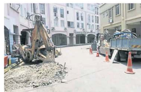
续“偷水”。水供公司甚至直接出动铲泥机挖土，以切断地下水管，避免有人继续“偷水”。
